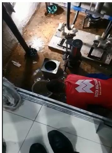
(Imagens extraídas de mídias anexadas às fls. 966 e 861, respectivamente, indicando falha no revestimento da piscina e alagamento no fosso do elevador.)
